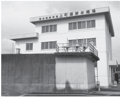
上町揚排水機場
