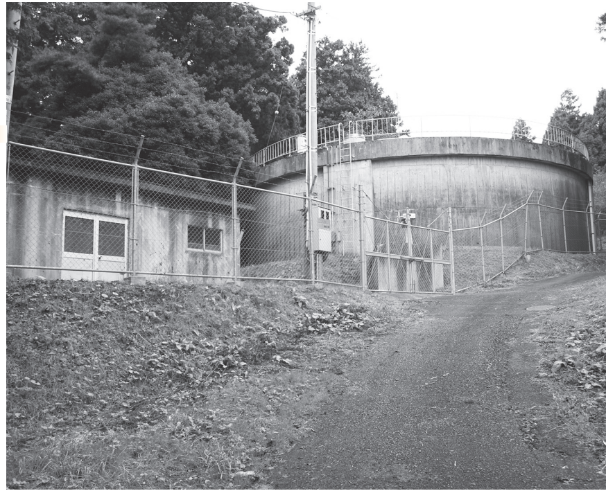
大崎広域水道から送られた水を一度貯めておく第1配水池
