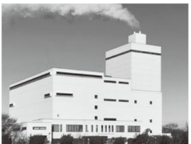
汚染廃棄物の焼却を行う 大崎広域東部クリーンセンター
