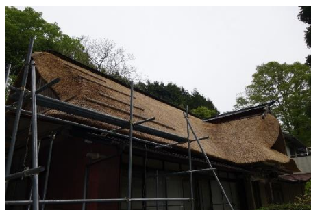
町指定仁王堂茅屋根修繕事業
