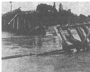
写真は、昭和49年8月の浦谷橋の流出。コンクリート製の浦谷橋の昭和50年度完成を前に、木造の橋が大雨によって流出。
