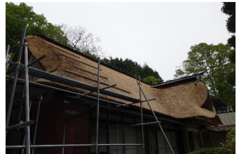
町指定仁王堂茅屋根修繕事業
