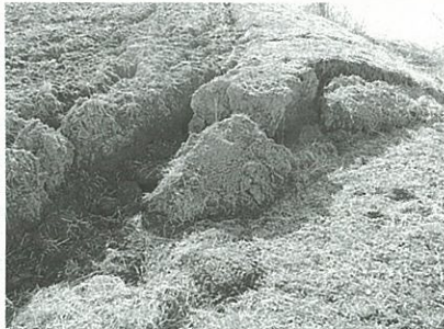
カントリーエレベーター基礎周辺の地盤陥没
