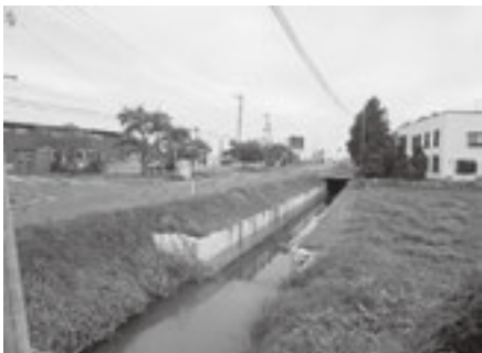
排水路整備 (田町裏地内)
