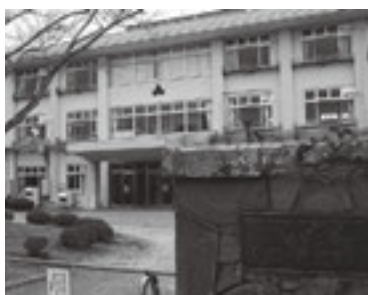
涌谷第一小学校
