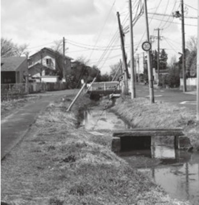
歩道整備を行う中道1号線
