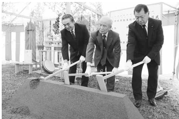
写真) 関係者で鍬入れされ建設工事が着工
